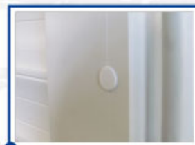
Bouchons Ø12 coulisses et tube IRO
